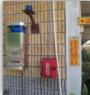
Consiste de una caja rectangular anclada en la pared exterior del edificio con un letrero de color amarillo intenso identificado con la palabra **TELÉFONO DE EMERGENCIA** en rojo. En
